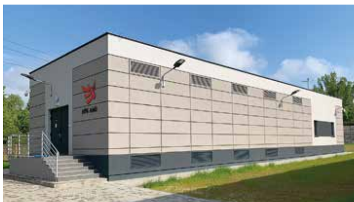
Nowa podstacja trakcyjna „Telefoniczna”
